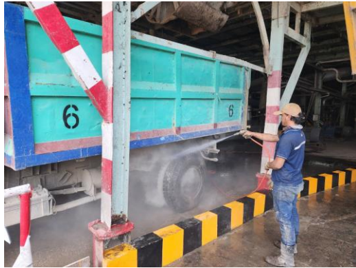
รูปที่ 131 บ่อล้างล้อรถบรรทุกบริเวณลานกองกากตะกอน และลานกองเถ้า
