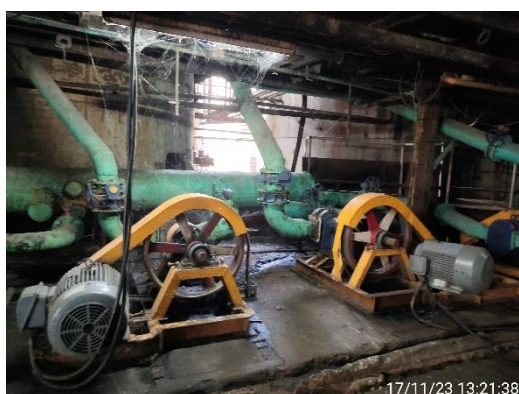
รูปที่ 96 เครื่องปั๊มกากน้ำตาล
