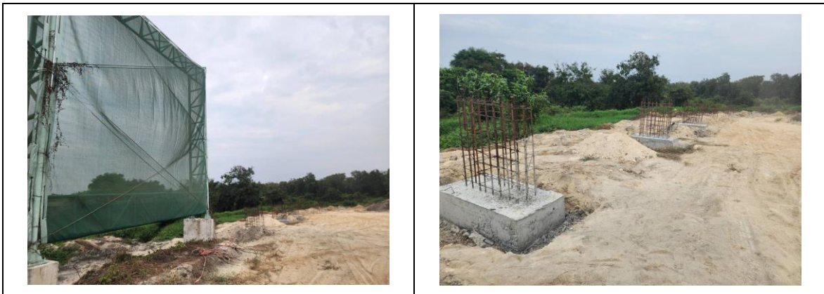
รูปที่ 30 การก่อสร้างติดตั้งเสาสำหรับติดตั้งแนวตาข่ายรอบลานกองกากตะกอนฯ
