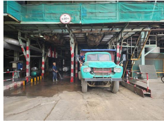
รูปที่ 131 บ่อล้างล้อรถบรรทุกบริเวณลานกองกากตะกอน และลานกองเถ้า
