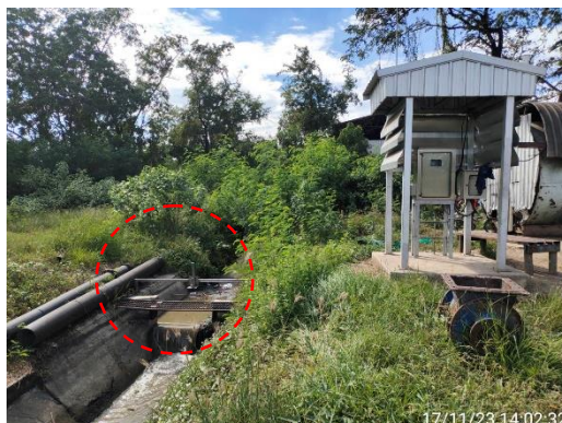
รูปที่ 48 การติดตั้งมิเตอร์ตรวจสอบปริมาณน้ำเสีย
