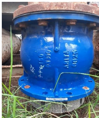
รูปที่ 55 การติดตั้งตะแกรงตาข่ายปลายท่อสูบน้ำแม่น้ำป่าสัก
